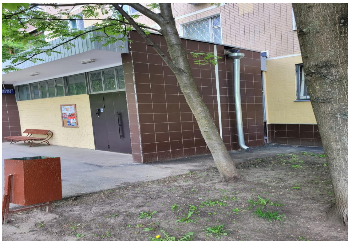
Контроль капитального ремонта, проводившегося по адресу: ул. Каргопольская, д. 17, к. 1.
